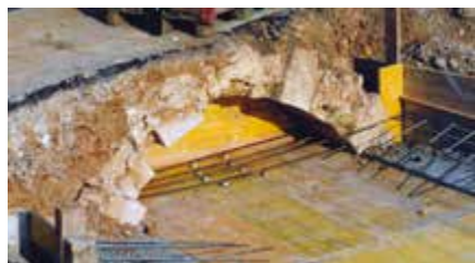
Gewölbe einer beim Bau der Staffeleggstrasse zwischen 1804 und 1810 erbauten Brücke über das Wabigebächlein unterhalb der «Sonne» in Ueken. (Foto 1993)
