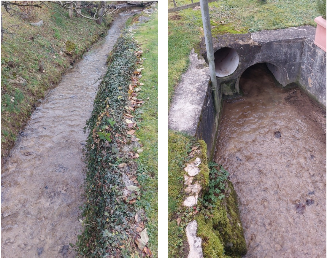
Abbildung 2: Gerinne Moosebächli gegen Fliessrichtung (links) und Durchlass in Fliessrichtung (rechts).
